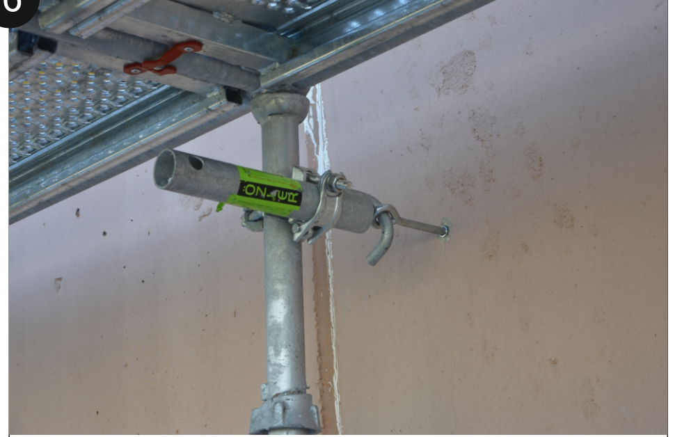
Tamamlanmış Boru Dayama sistemi.
