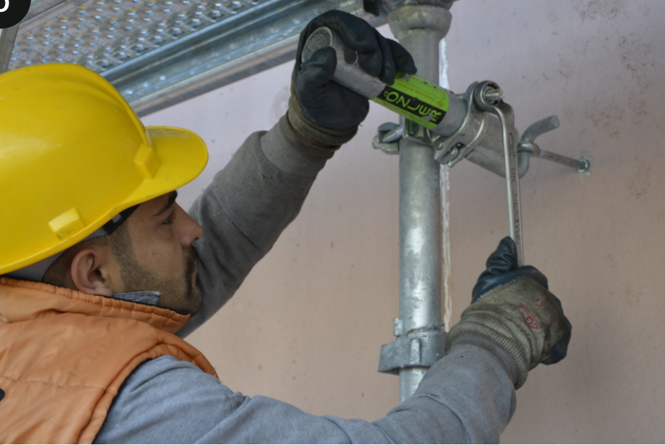
Sabit Kelepçenin Boru Dayama yönündeki Somun sıkılır.
