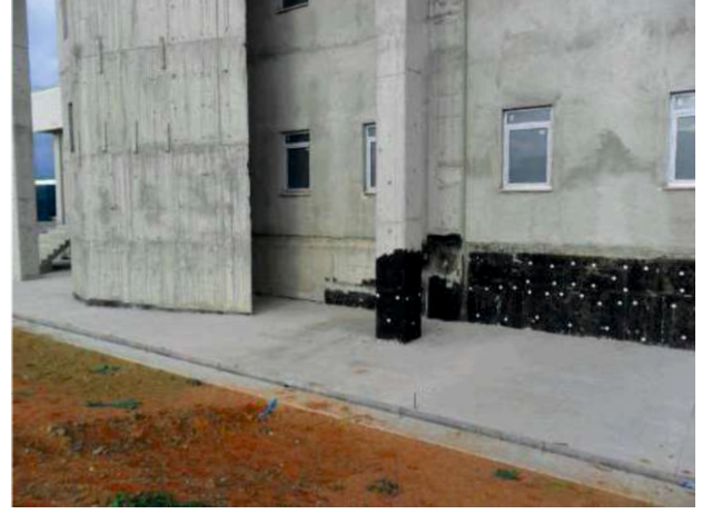
İskele Kurulumuna Uygun Zemin
